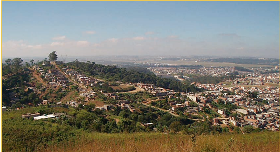
Figura 23 | Bairro Cabuçu, Guarulhos. Fonte: Rodrigo Machado (2007).
