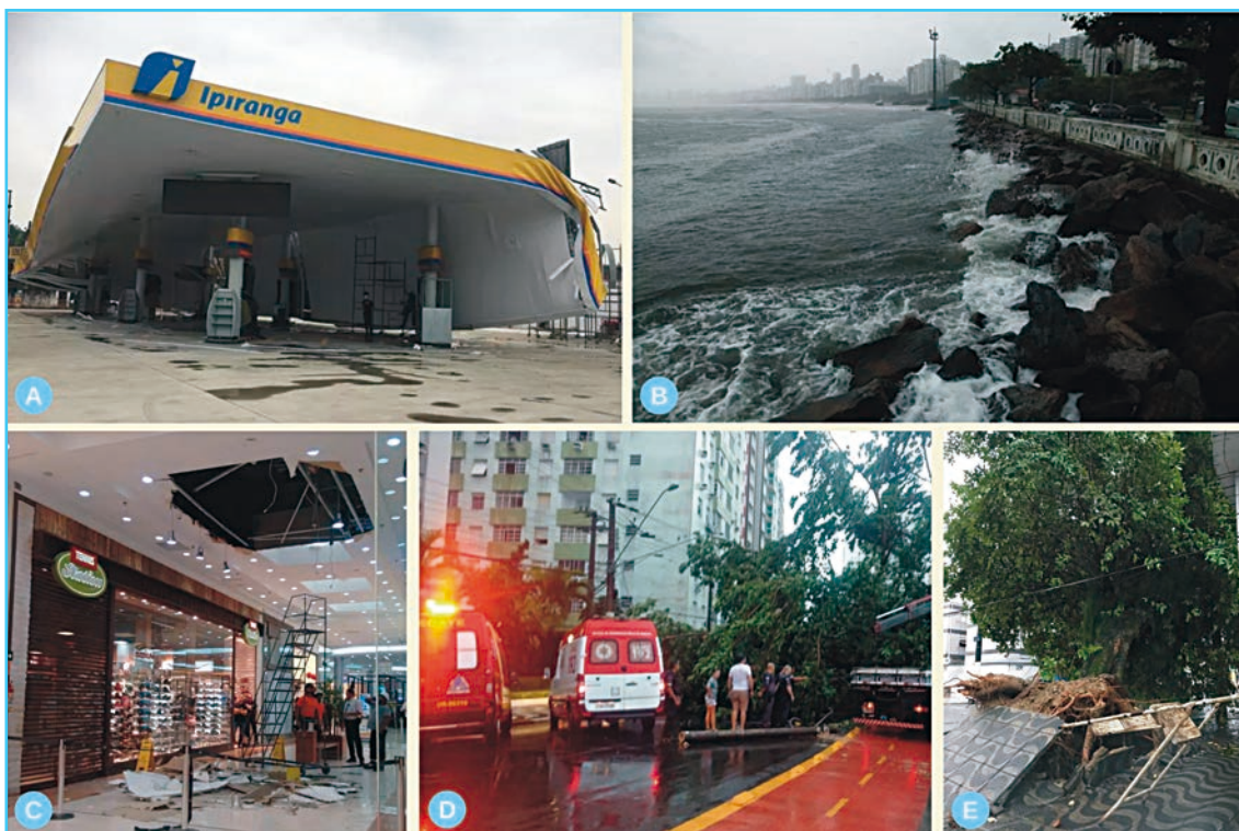
Figura 28 | Registros fotográficos de impactos relacionados a eventos climáticos na RMBS: queda de marquise de um posto de combustíveis em Santos (A); maré alta e ressaca em Santos (B); desabamento do teto do shopping de Praia Grande (C); árvore que caiu sobre dois ambulantes, na Praça Carlos Antonio Menon, em São Vicente (D); queda de árvore com destruição de calçada em Santos (E). Fotos: Marcela Pierotti/G1 (A); Francisco Arrais/Prefeitura de Santos (B); Reprodução (C); Bruno Maraccini (D); Vanessa Rodrigues (E). Fonte: G1 Santos e Região (2018; 2019).
