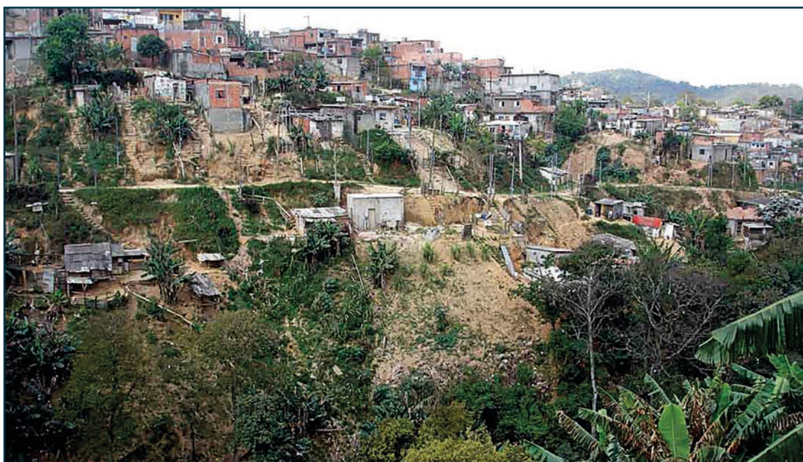
Figura 7 | Degradação dos serviços ecossistêmicos pela ocupação irregular do loteamento do Novo Recreio na periferia de Guarulhos, e manifestação de erosões e escorregamentos. Fonte: A.M.S. Oliveira (nov. 2007).
