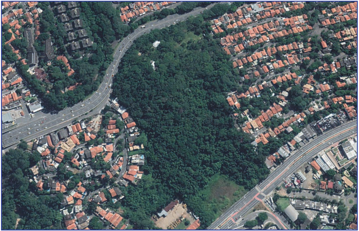
Figura 11 | Imagem aérea do Parque da Previdência, no Jardim Ademar, em São Paulo. Fonte: Google Earth (2019).
