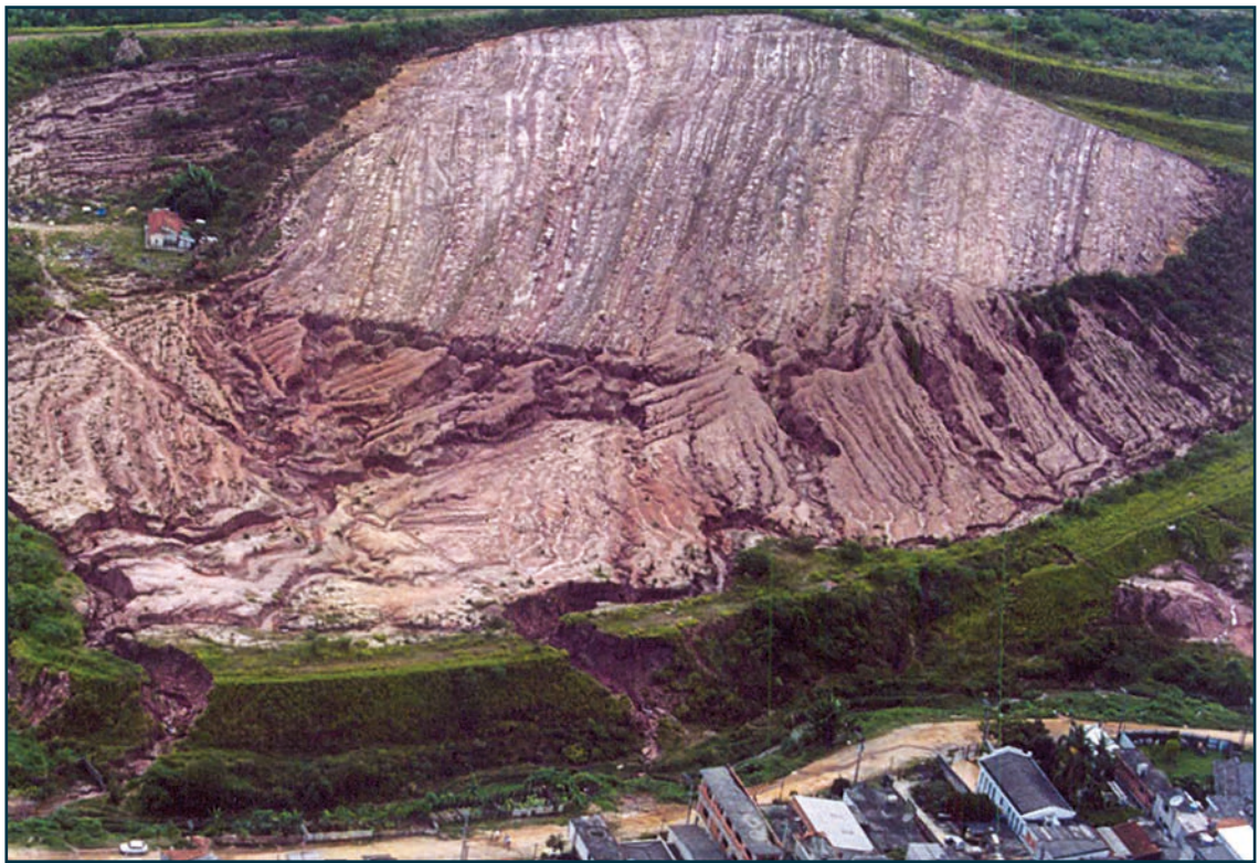
Figura 9 | Intensos processos erosivos nos aterros de área terraplenada para loteamento em São Paulo. Fonte: Arquivo do IPT (2004).
