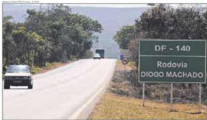
Trabalho de engenharia da obra para as obras da futura RBC, que terá entre o Jardim Botânico e Santa Maria, nas proximidades do Tororó
